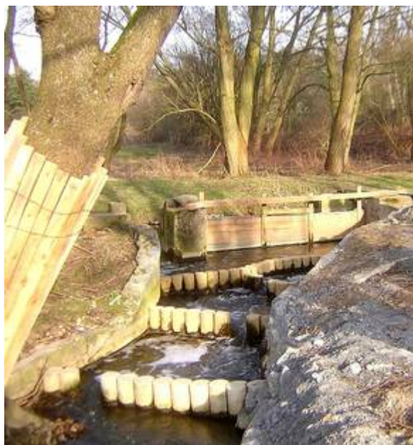
Die bereits fertig gestellte Fischtreppe am 19.3.2010.
