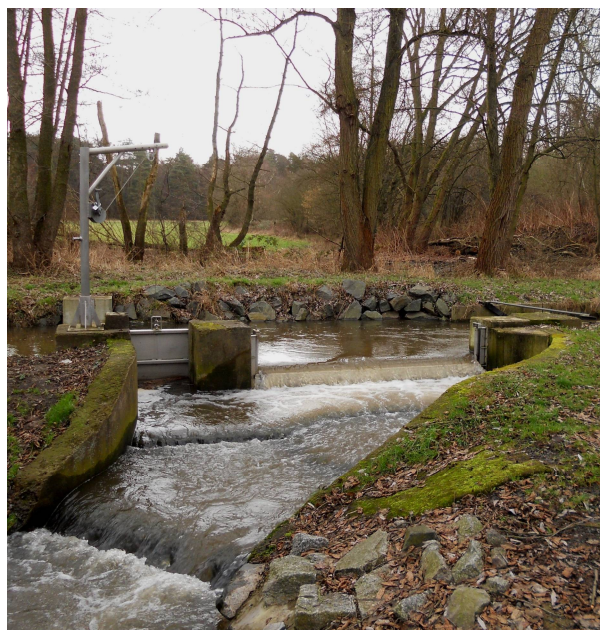
Das Bauwerk nach Abschluss der Umbauarbeiten am 31.1.2013. Fotos: P. Erlemann
