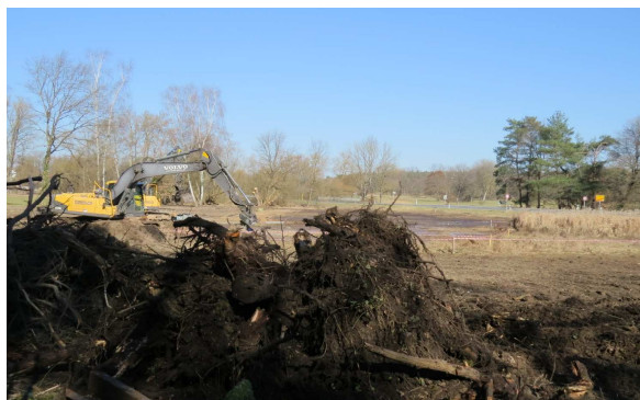
Sanierungsarbeiten im Februar 2021
