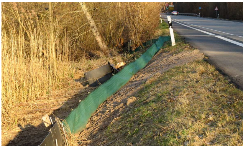
Die Lücke wurde provisorisch geschlossen.
