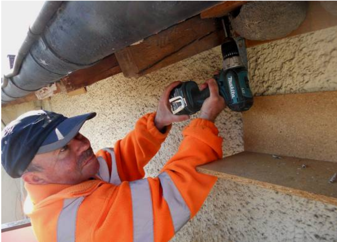
Günther Lang befestigt ein Kunstnest unter dem Dachüberstand. Ein darunter montiertes Kotbrett soll Verunreinigungen der Hausfassade verhindern. Foto: P. Erlemann, 16.4.2014
