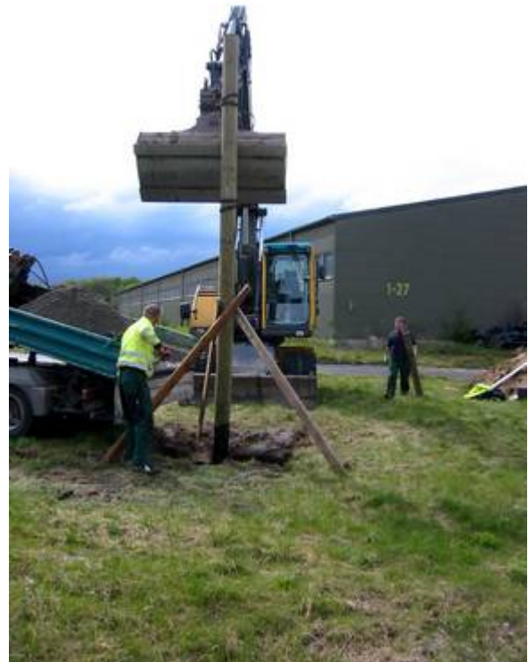
Aufstellen des Holzmastes.
