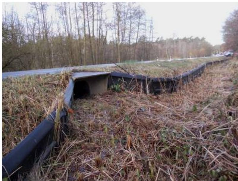
Die Absperrungen an den Schneisen wurden instand gesetzt und die Funktionsfähigkeit von Leitzaun und Durchlässen überprüft – alles ist bereit für die Wanderung der Amphibien zu ihrem Laichgewässer.
