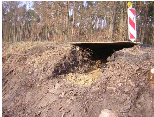
Austrittsstelle von einem der beiden Tunnel
